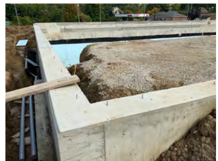
Anchors for Stud Wall Framing
