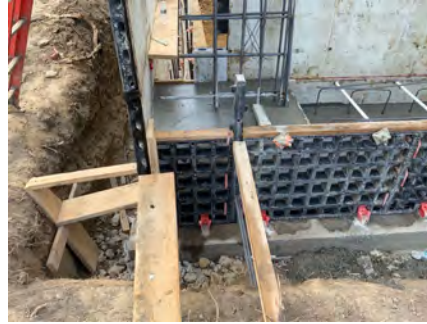
Concrete Framing and Pour
