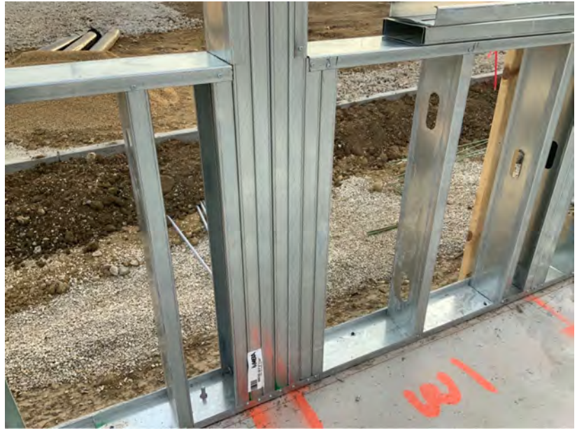
Metal Stud Jamb at Windows
