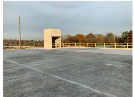
Slab on Grade Pour
