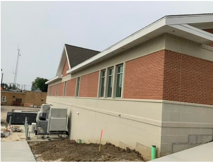
Exterior NE Corner
