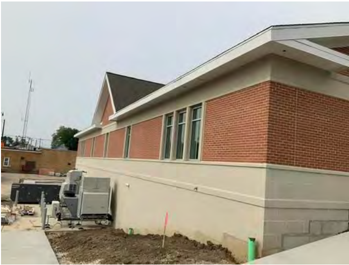
Exterior NE Corner
